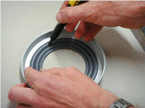
Bei Übergrößen (z.B. Prefa) sollte an der Markierung entsprechend nachgeschnitten werden. Dies sollte sorgfältig und auf einer Holzunterlage erfolgen, ein etwaiger Falz vom Fallrohr kann ebenso freigeschnitten werden.
